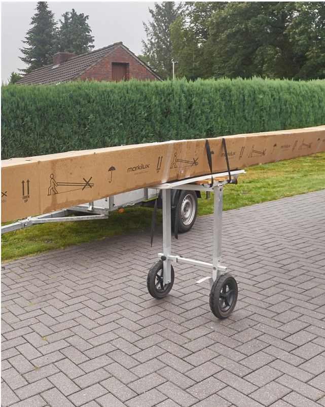
Transport der Markise zur Montagestelle mit einer kleinen und wendigen Transporthilfe.
