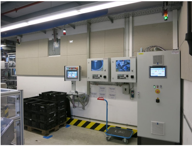
Akustikplatten - Wände
