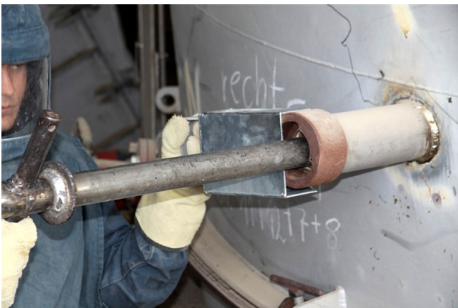
Phase 1; Ziehen, Cardoxrohr
