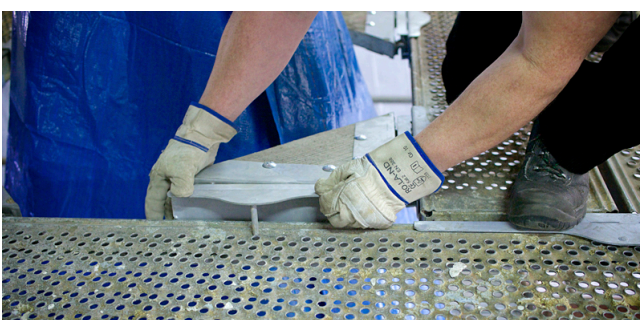
Bisher ein Schwachpunkt beim Einsatz von Systemgerüsten: Bei Aussparungen oder runden Baukörpern werden Bohlen zum Abdecken von Öffnungen eingesetzt.
