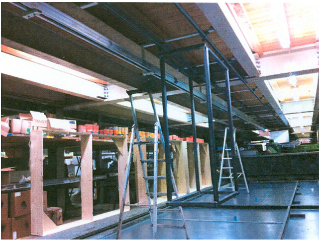
Beginn der Installation 1
