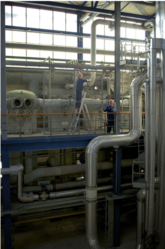
Positionierung des Schutzgitters
