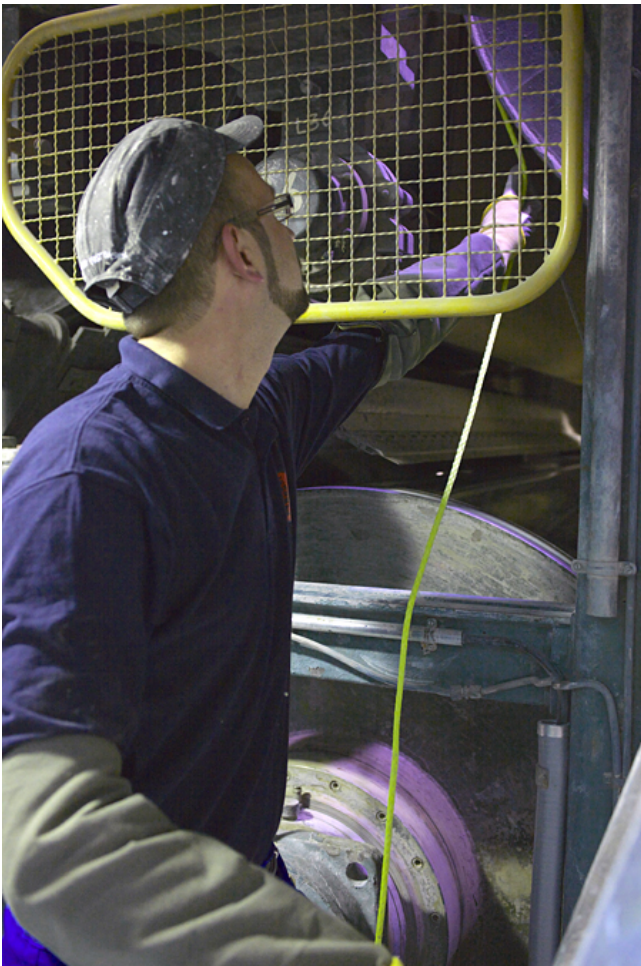
Einziehen des Aufführseils
