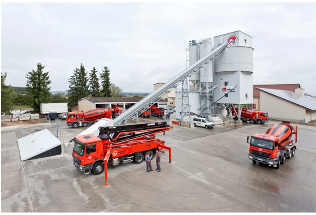
Moderne Transportbetonanlage der Firma Würnitz
