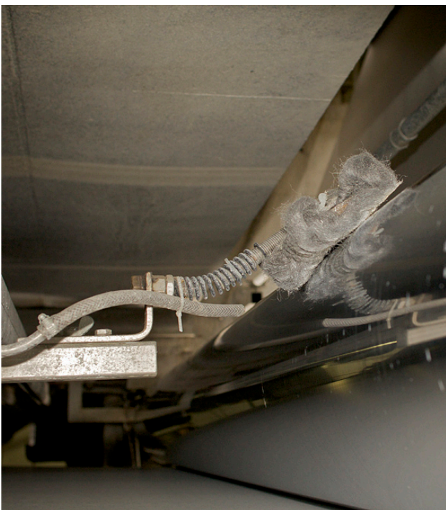
Eng, feucht und heiß: die Haltevorrichtung mit den auswechselbaren Reinigungseinsätzen erspart den Mitarbeitern den Einsatz in einer gefährlichen Umgebung.
