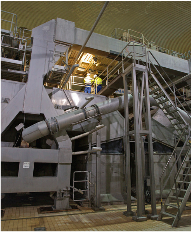
Treppen, Laufstege und Absturzsicherungen ...
