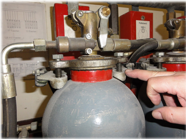
Wiegevorrichtung mit gefüllten Gasflaschen.
