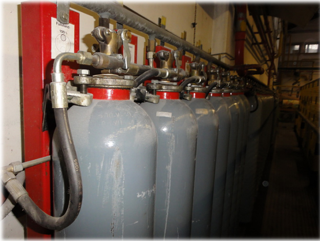
Gasflaschen (hier 45 Stück) hängen in Wiegevorrichtung.
