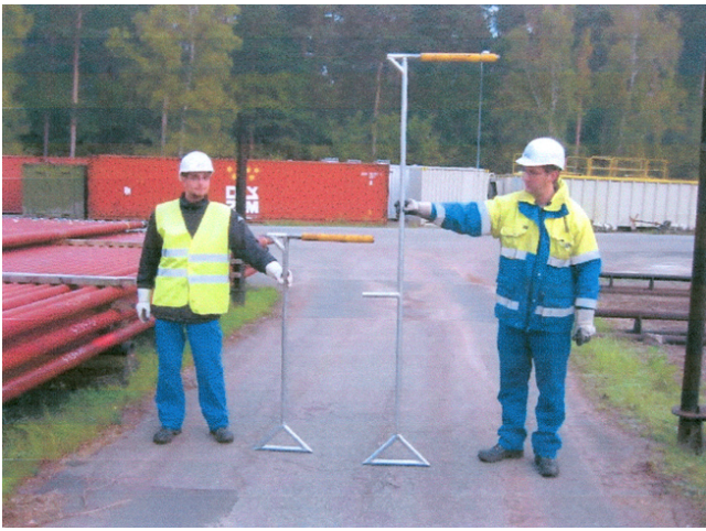
Die beiden Tools zum Rollen der Rohre.
