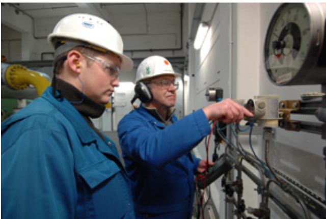
Erfahrene Mitarbeiter der Fremdfirma begleiten die „Neuen“ bei der Ausführung der Arbeiten im Betrieb. Der Status „neuer Mitarbeiter“ währt ein halbes Jahr und wird durch einen Vermerk in einem Sicherheitspass kenntlich gemacht, den jeder Beschäftigte der Erdöl- und Erdgasindustrie bei sich hat.
