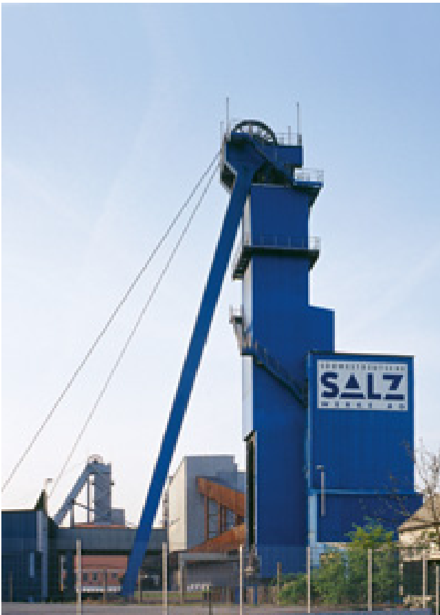
Schacht Franken der Südwestdeutschen Salzwerke mit Sitz in Heilbronn
