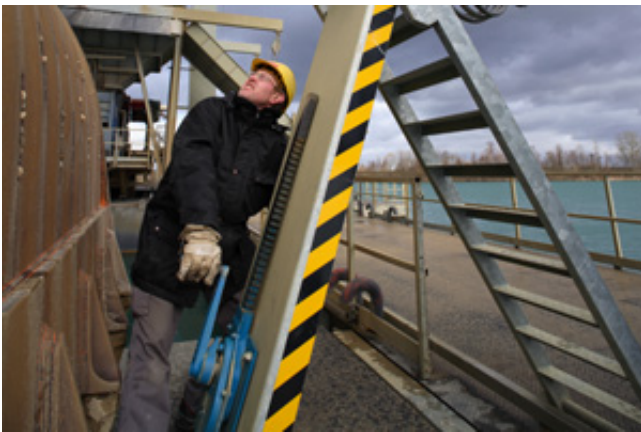
Ausrichten der Treppenleiter
