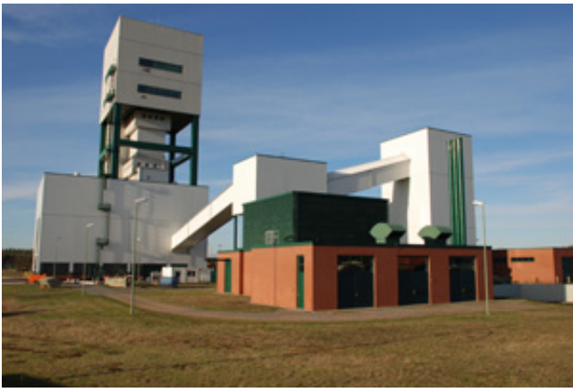
DBE Erkundungsbergwerk Gorleben
