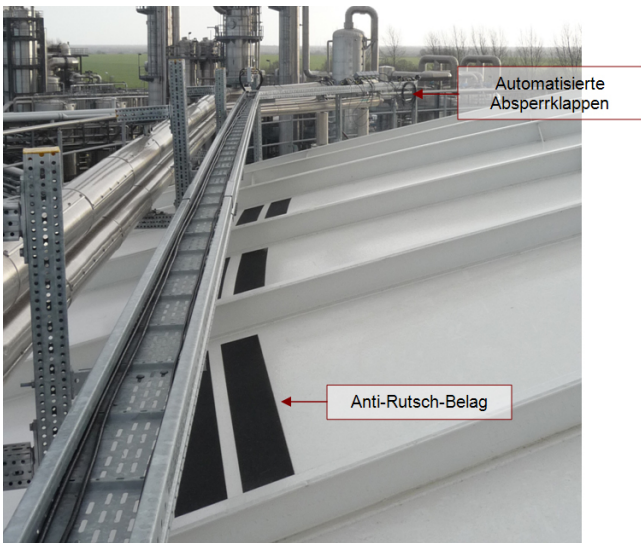
Abb. 2: Tankoberseite mit bereits installiertem Kabelkanal
