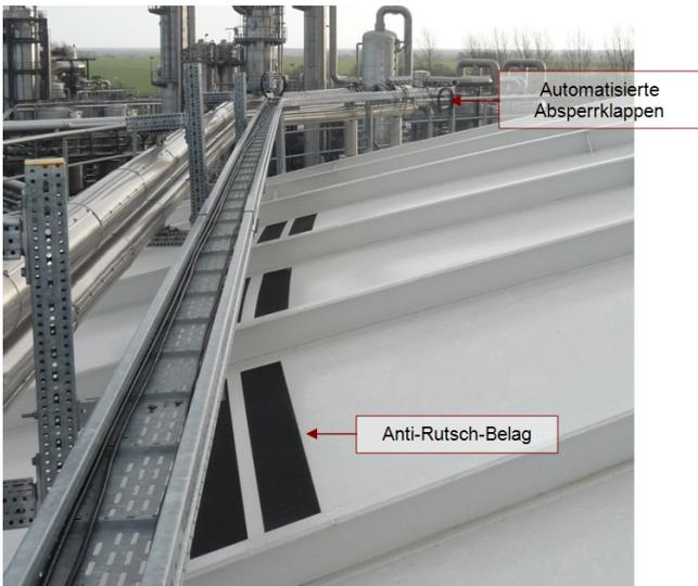
Abb. 2: Tankoberseite mit bereits installiertem Kabelkanal
